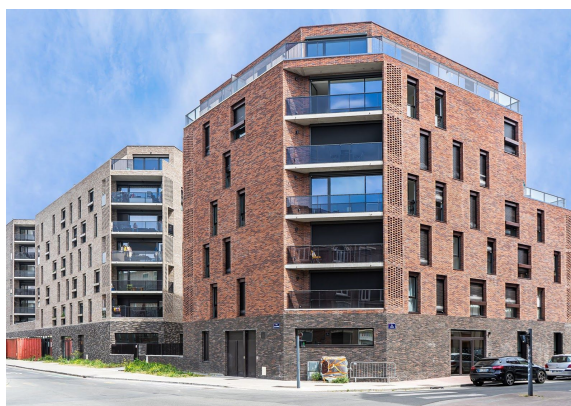
Photo by Bouygues Bâtiment 5
